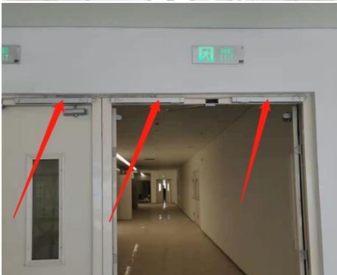
电动闭门器安装
